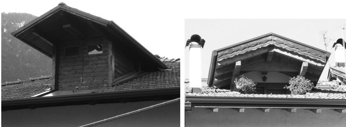
Soluzioni ammesse: abbaino per montacarichi – abbaino con minibalcone interno.
